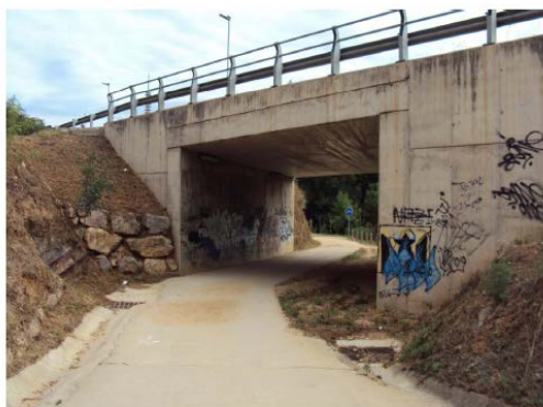
Foto núm. 4: Vista general i de les arquetes pluvials del pas sota la GIV-6703 direcció Girona.
