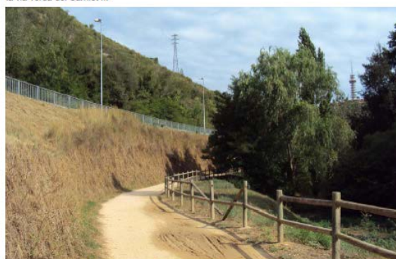
Foto núm. 1: Vista general de la via verda direcció Girona després del pas inferior.
