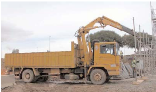
Equip de treball format per un vehicle portant, dotat amb sistemes de propulsió i direcció propis, sobre el xassis del qual s'acobla un aparell d'elevació tipus ploma.
