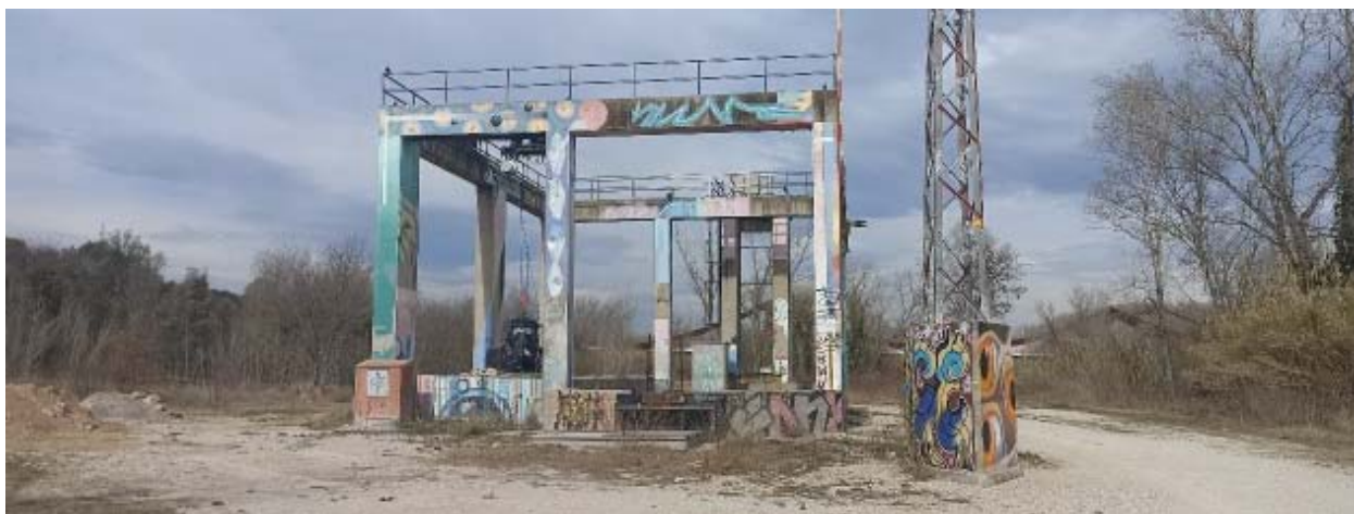
Foto 1: Instal·lació del desbast existent previ al creuament del riu Ter, marge esquerra, darrera Hospital Josep Trueta .
