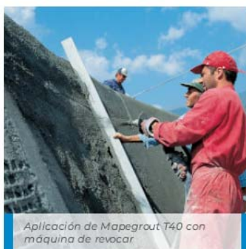
Acabado de Mapegrout T40 con fratas
