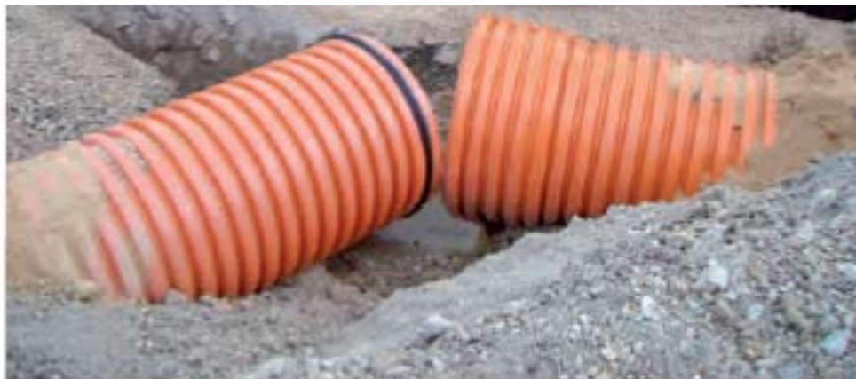
TUBERÍAS DE PVC CORRUGADO (COLOR TEJA) Y
