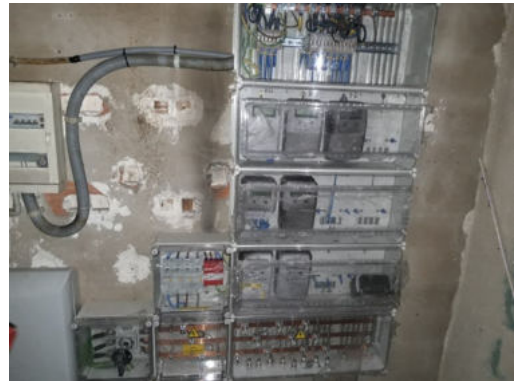
Exemple de centralitzacions actualitzades en un correcte estat
