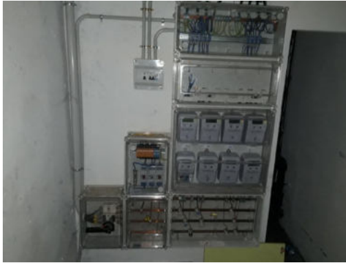
Exemple de centralitzacions actualitzades en un correcte estat
