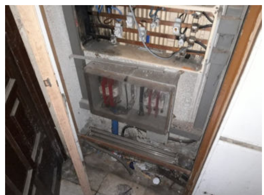
Exemple de centralitzacions de comptadors en estat deficient
