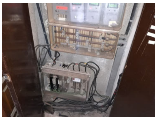
Exemple de centralitzacions de comptadors en estat deficient
