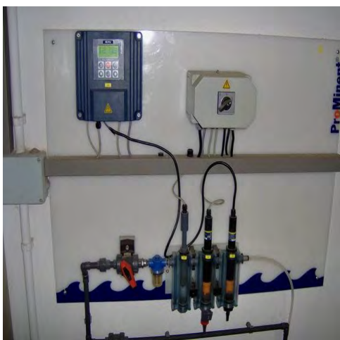
Sondes amperomètriques de clor lliure
