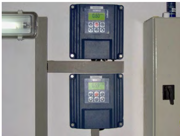
Analitzadors amperomètrics de Clor Lliure
