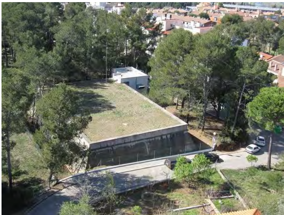
Central de Montjuïc
