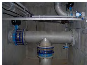
Sortida d'un filtre de Carbó Actiu
