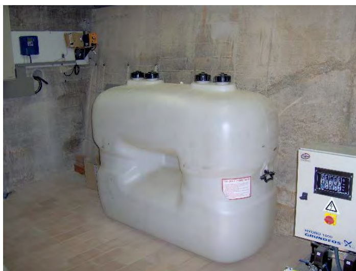
Dipòsit d'Hipoclorit Sòdic de l'estació del Puig d'en Roca
